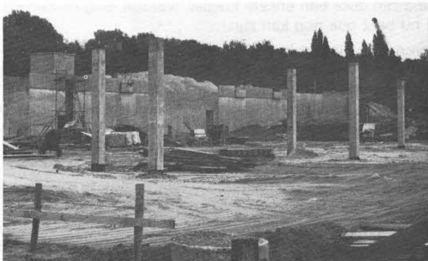
◀ Het in opbouw zijnde station van Genk, op 1 oktober 1978. Foto Th. Heylen.
